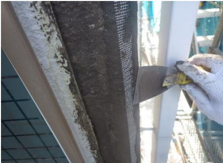
ファイバーテープと弾性補修剤で補強
