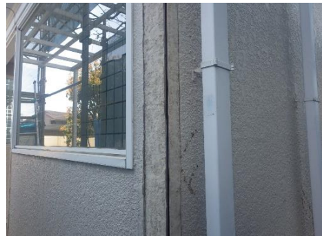
補強下地処理完了
