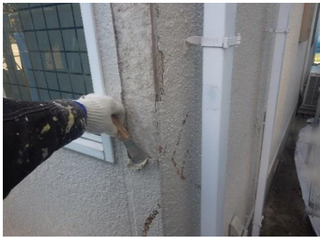
ファイバーテープと弾性補修剤で補強
