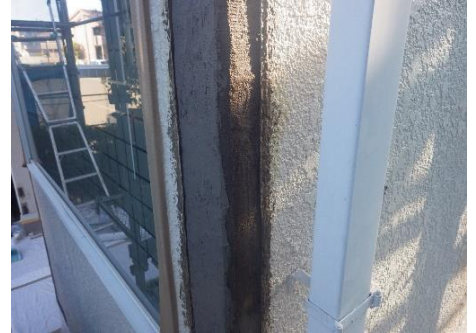
補強下地処理完了
