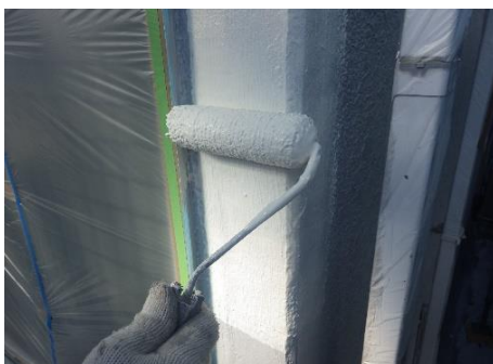
保護防水塗装（主材3回+仕上材2回塗り）
