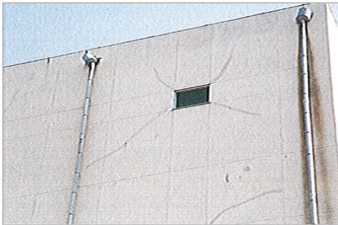
施工後の数年経過
